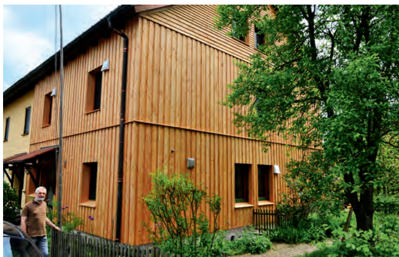
◀ Bild 5 • Die beheizte Wohnfläche beträgt insgesamt 160 m 2 , davon 120 m 2 Fußbodenheizung und im Dachgeschoss Heizkörper. Neben den Fenstern die Lüftungsventile der dezentralen Be- und Entlüftungsgeräte mit Wärmerückgewinnung. Im Bild Christof Bärhausen.
