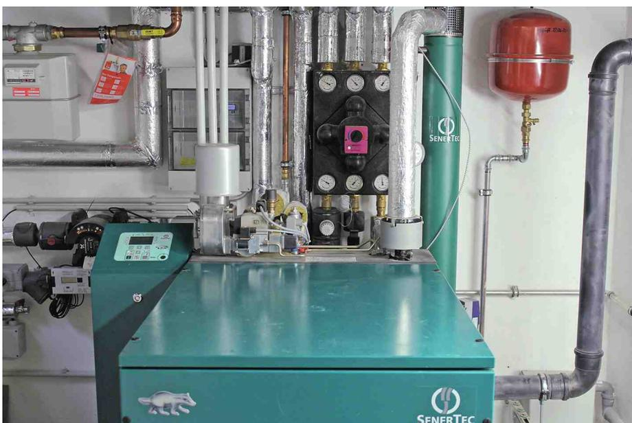
Der zwischen BHKW und Pufferspeicher geschaltete Rendemix bewirkt, dass die Puffer nach dem Zwei-Zonen-Prinzip beladen werden und sorgt gleichzeitig für die Rücklaufanhebung zum BHKW.
