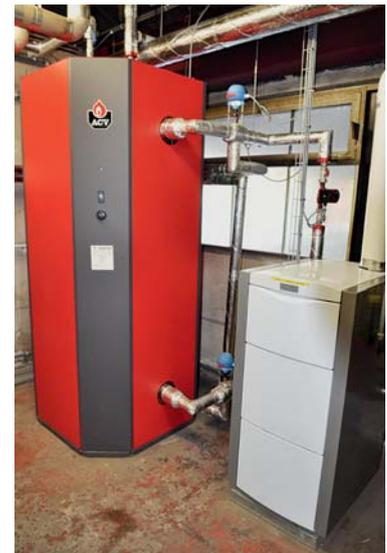
19-kW-Ölbrennwertkessel (Vaillant icovIT) zur ganzjährigen Warmwasserbereitung
