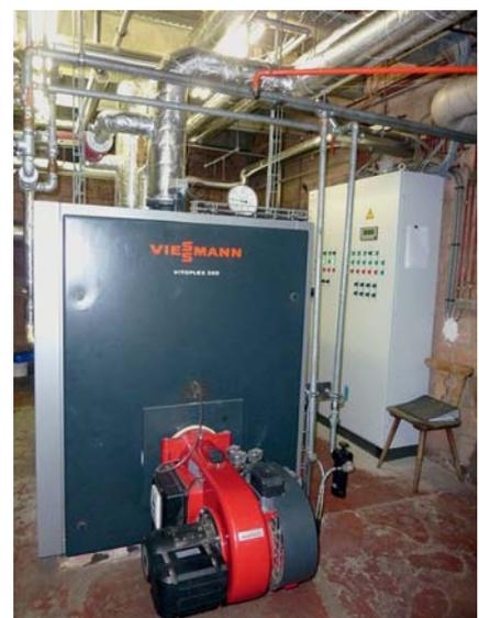
Bis zu 85 °C Vorlauftemperatur aus dem Ölbrennwertkessel (Viessmann Vitoplex) mit 700 kW Leistung
