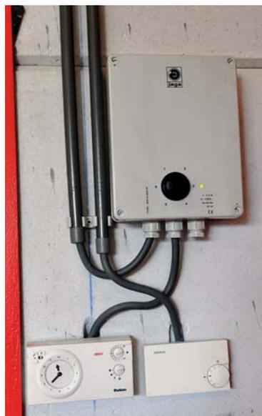
... sowie mit Frequenzumformern zur Drehzahlregelung der Ventilatoren
