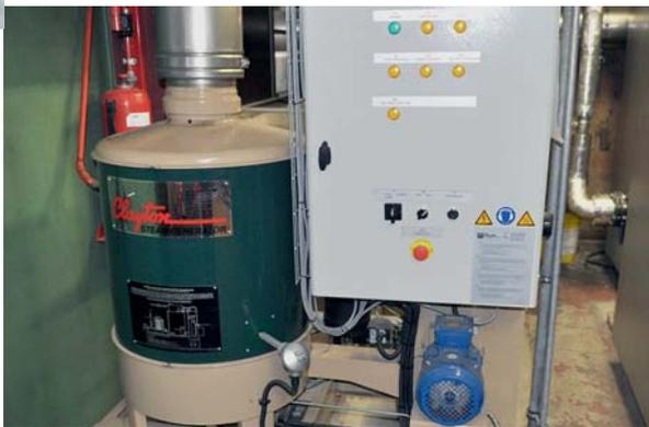
Erneuerter heizölbefuerter Dampferzeuger (Durchlaufprinzip) zur bedarfsgerechten Beheizung der Mischbehälter in der Produktion, Dampfproduktion bei 1 bar 157 kg/h
