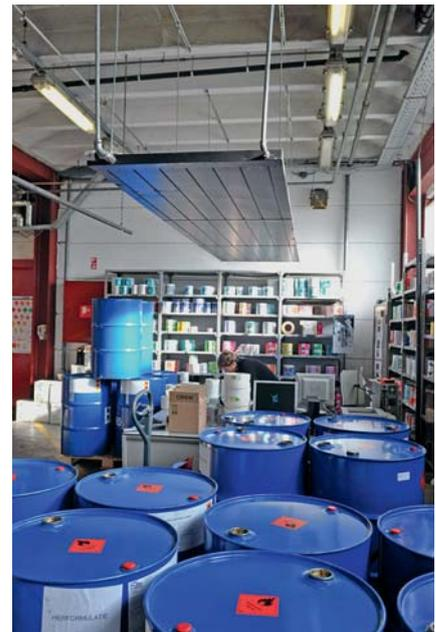
Warmwasserbeheizte Deckenstrahlplatten statt Warmluft im zwangsgelüfteten Arbeitsbereich
