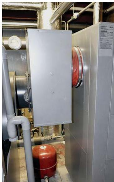
Der externe Latentwärmetauscher hinter dem Ölkessel (ganz rechts, Viessmann Vitotrans) gestattet den Anschluss eines separaten Heizungsrücklaufs und damit Brennwertnutzung bei hohen Vorlauftemperaturen (Erklärung siehe Text). Die silbergraue Abgasbox zwischen Tauscher und Kessel gleicht lediglich die unterschiedlichen Höhen von Kesselausgang und Wärmetauscher-eingang aus
