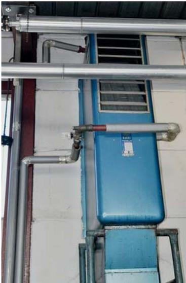
Die vorhandenen Lüfter wurden nicht ausgetauscht, aber mit Thermostatventilen als Rücklauf-Temperaturbegrenzer brennwerttauglich nachgerüstet ...
