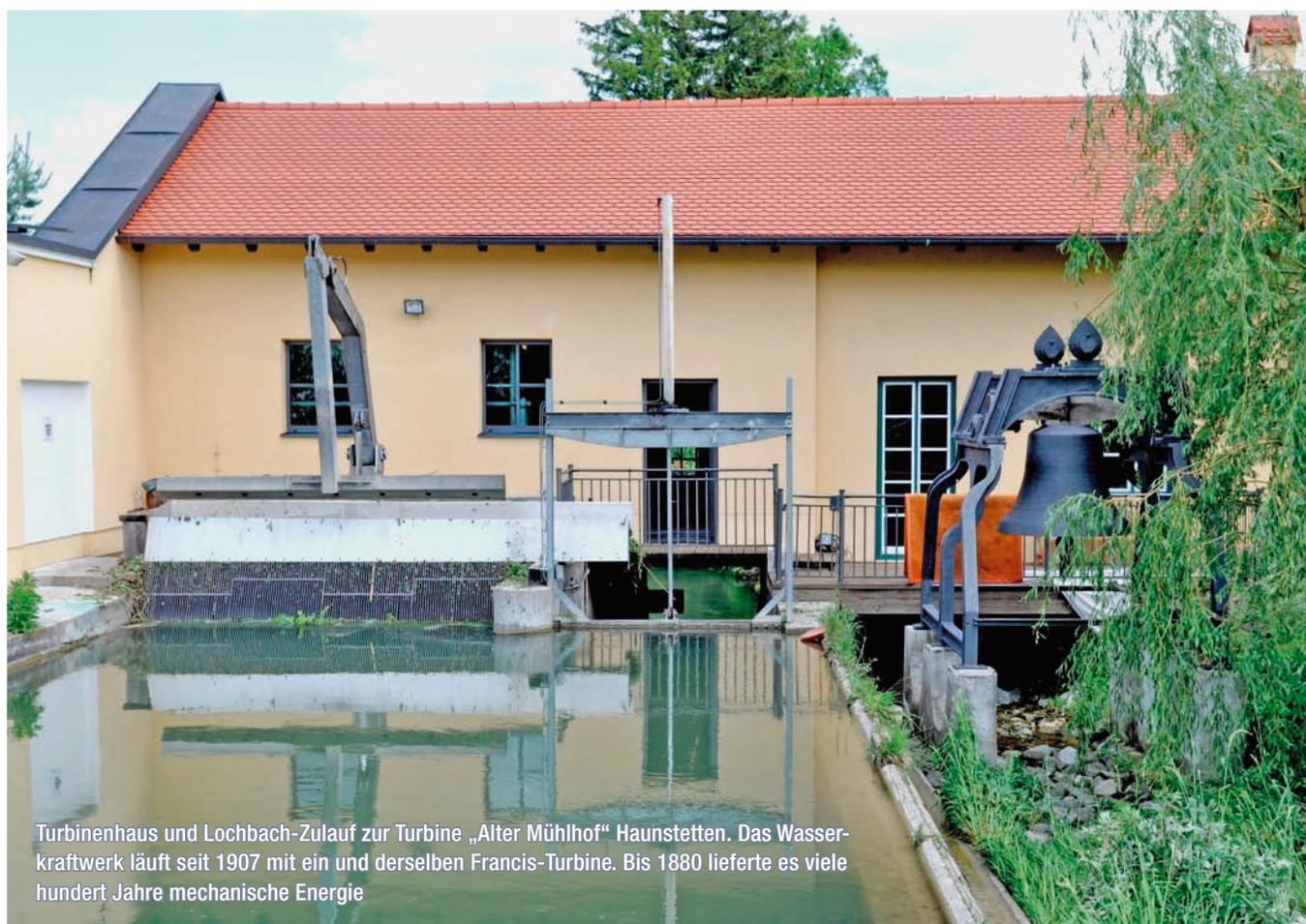
Turbinenhaus und Lochbach-Zulauf zur Turbine „Alter Mühlhof“ Haunstetten. Das Wasserkraftwerk läuft seit 1907 mit ein und derselben Francis-Turbine. Bis 1880 lieferte es viele hundert Jahre mechanische Energie
