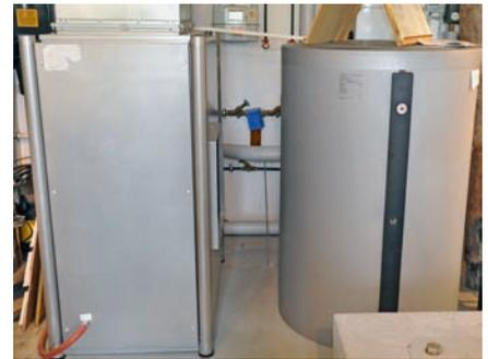
Für die Wärmerückgewinnung im Turbinenhaus sind die Wärmepumpe (links, Vitocal/Viessmann) und der 300-l-Pufferspeicher (Vitocell/Viessmann) zuständig
