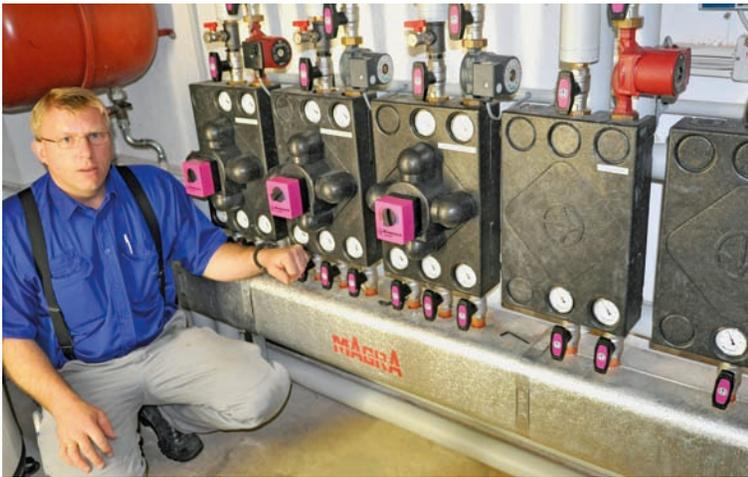
Mischerguppe. Die drei Einheiten links sind die „Rendemix“-Mehrwegemischer, die beiden Einheiten rechts Armaturenboxen zur unregelmäßigen Wärmeversorgung des Wärmetauschers Schwimmbadwasser und der Warmwasserbereitung (im Bild Johannes Jacob, Albert Kohl Wasser und Wärme GmbH)
