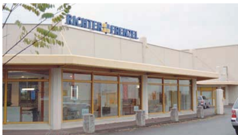
Das Heizsystem in der Niederlassung des SHK-Fachgroßhandels Richter + Frenzel in Schweinfurt wurde energetisch optimiert. Der Hauptansatzpunkt galt dabei der Anlagenhydraulik. Bild: W. Heintz
