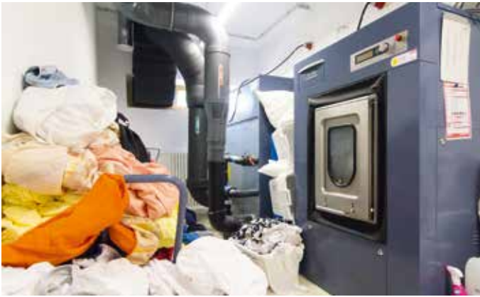
Die Industriewaschmaschine (vorn) und der Wäschetrockner. Beide arbeiten mit der Wärme des BHKWs, nur beim Kochwäsche-Programm heizt die Waschmaschine elektrisch nach.
