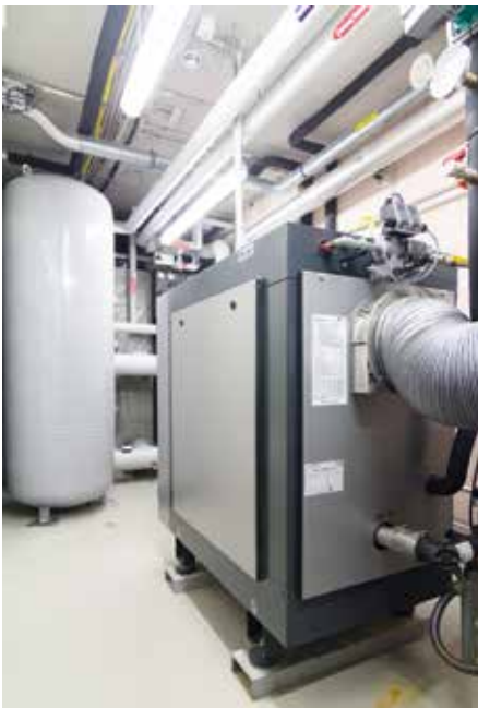
Ein Viessmann-BHKW (vorn) und ein 3 m 3 fassender varmeco-Wärmespeicher (hinten links) versorgen die „Inklusiven Wohnwelten“ mit Wärme. Ergänzt wird die Anlage von einem 80-kW-Spitzenlast-Brennwertkessel.
