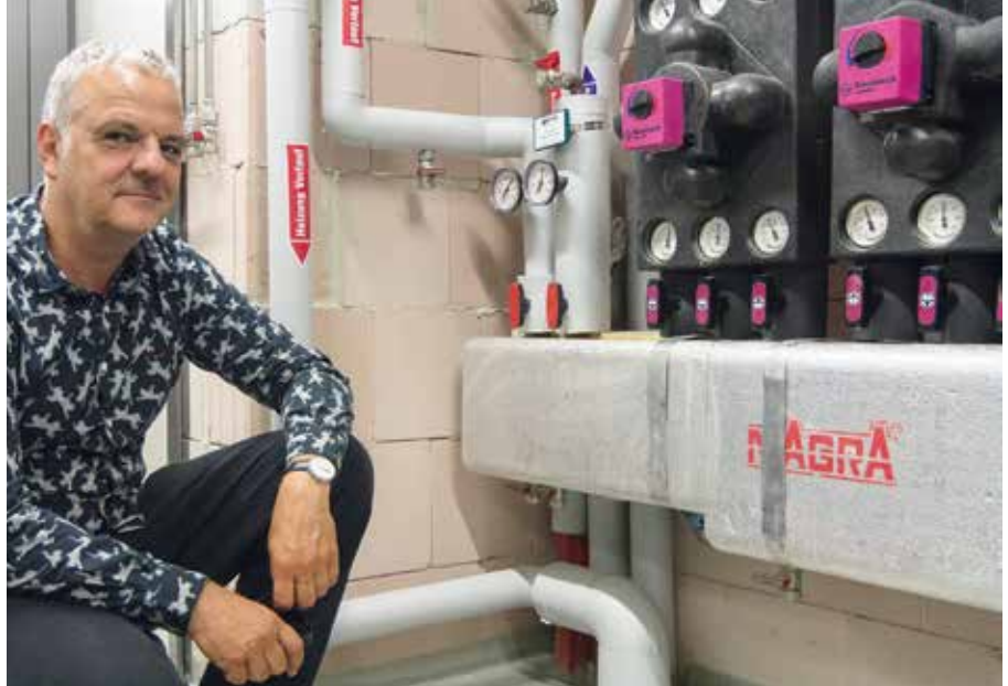
Fachplaner Roland Goetz vor den Mehrwege-Verteilern. Sie machen den Rücklauf eines Hochtemperatur-Wärmekreises für den Vorlauf eines Niedertemperaturkreises nutzbar. Das maximiert die Temperaturspreizung und somit die thermische Effizienz.
