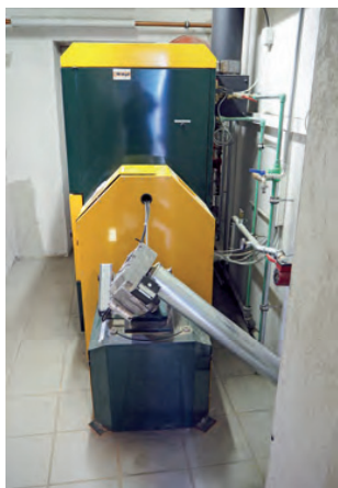
Die Wärmelieferanten: Pelletskessel, neuer Pufferspeicher mit Wärmeübertrager und Kälteanlage.
