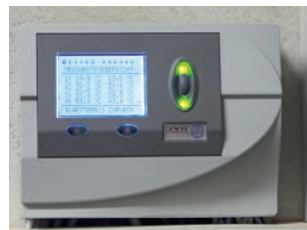
Neuer UVR-Regler im Heizraum.
