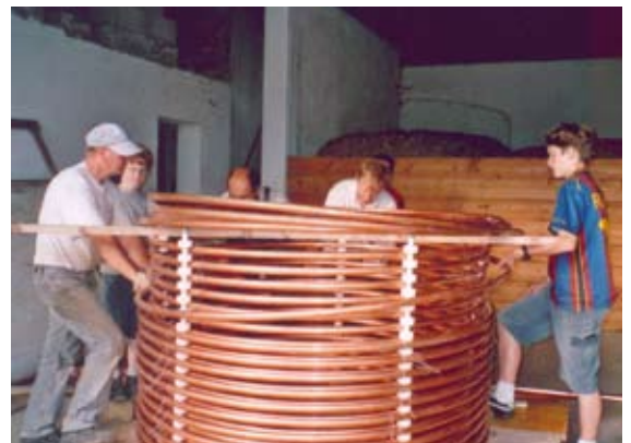
Beim Bau des Kupferrohr-Wärmetauschers für den Solarspeicher war die Mithilfe der ganzen Familie gefordert, bevor ...
