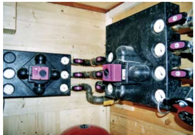
Das gesamte Verteil- und Regelsystem für die hydraulische Schaltung der Heizungs- und Solaranlage mit Groß-Pufferspeicher besteht aus zwei rendeMIX Mehrwege-Mischverteilern und passt auf etwa 1 m 2 Wandfläche.
