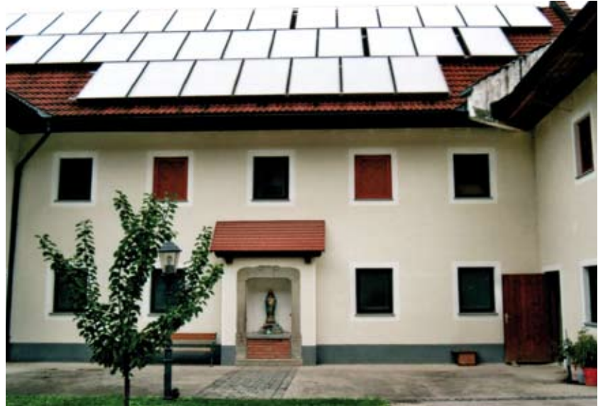
Eine 88 m 2 große Solar-Kollektorfläche deckt von April bis Oktober den Wärmebedarf.
