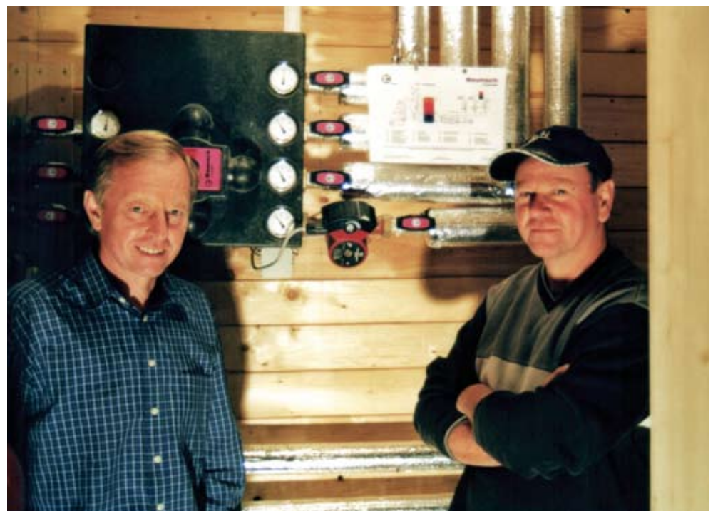
Das gesamte Verteil- und Regelsystem für die hydraulische Schaltung der Heizungs- und Solaranlage mit Groß-Pufferspeicher besteht aus zwei rendeMIX Mehrwege-Mischverteilern und passt auf etwa 1 m 2 Wandfläche.
