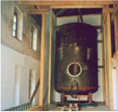
Der Solar-Pufferspeicher misst 4,5 m Höhe und fasst rund 22 m 3 Heizwasser.
