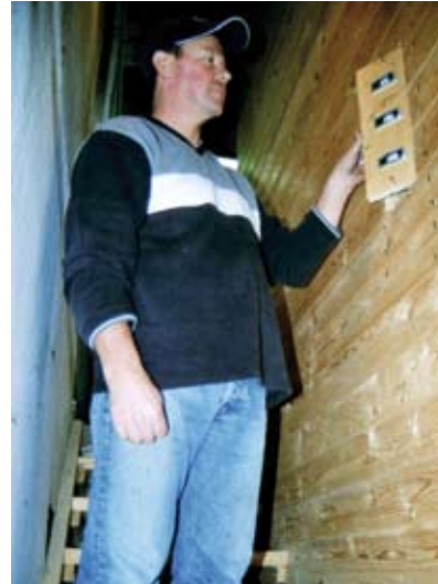
In die Holzver-schalung des umbauten und gedämmten Pufferspeichers hat Walter Grabner auf Sichthöhe drei Thermometer integriert, um die Temperaturen in der oberen, mittleren und unteren Pufferzone zu kontrollieren.
