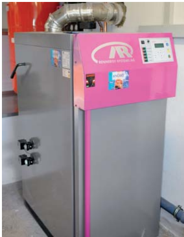
50 kW Leistung hat der Stückholzkessel der Firma Rennergy, Kempten/Allgäu
