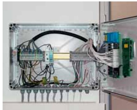
**Clevere Verschaltung: Zwei Relais-Schaltungen sorgen für ein geregeltes Öffnen und Schließen des Mischers.**
