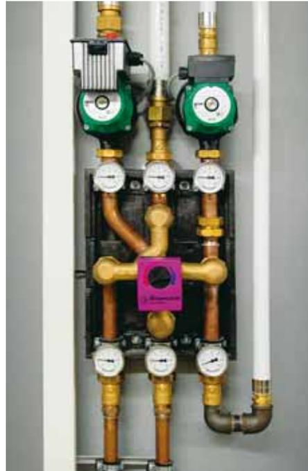
**Das Herzstück des Heizungssystems: Der Mehrwege-Mischverteiler rendeMIX 3x3 L35 stellt die Schaltzentrale der Heizungsanlage dar: Mit seiner Hilfe ergänzen sich Solaranlage und Wärmepumpe, statt sich in der Leistung zu beeinträchtigen.**
