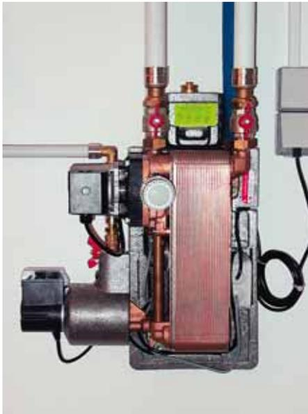
**Sichere Brauchwasserversorgung: Ein Sonnenkraft-Frischwassermodul sorgt für Sicherheit und Komfort bei der Warmwasserversorgung. Es arbeitet nach dem Durchflussprinzip: Über einen Wärmetauscher wird die gewünschte Menge Frischwasser auf Abruf erwärmt. Mit dem Thermostatknopf stellt man die entsprechende Brauchwassertemperatur ein. (Alle Bilder und Grafiken: Baunach)**
