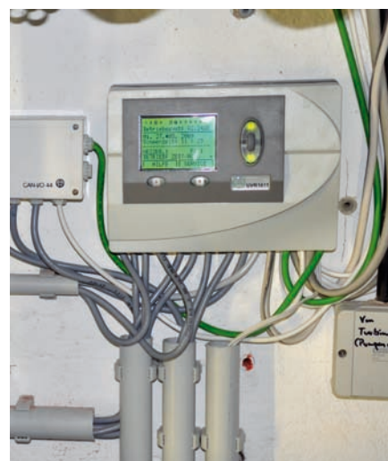
Frei programmierbare Regelung von der Fa. Technische Alternative, Amaliendorf/Österreich
