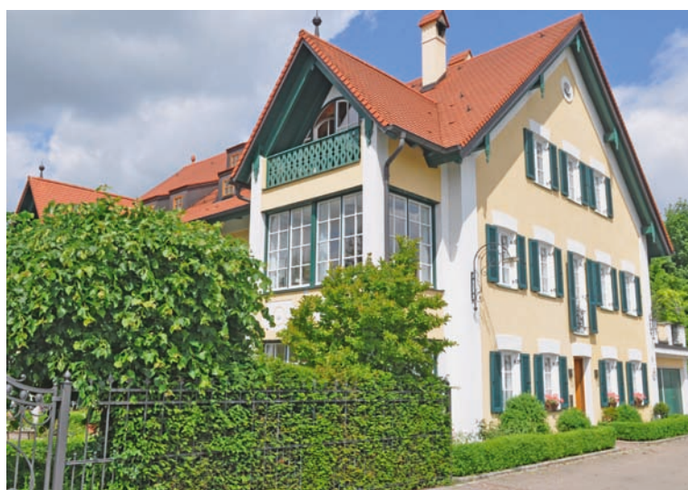
Haupthaus „Alter Mühlhof. Zu beheizen sind ca. 500 m 2 Wohnfläche, eine Schwimmbadhalle sowie das Beckenwasser
