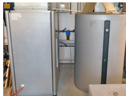
Für die Wärmerückgewinnung im Turbinenhaus sind die Wärmepumpe (links, Vitocal/Viessmann) und der 300-l-Pufferspeicher (Vitocell/Viessmann) zuständig
