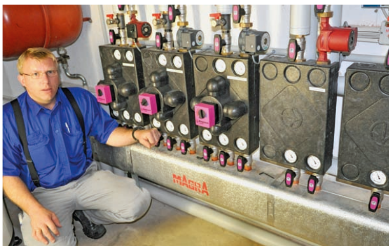
Mischergruppe. Die drei Einheiten links sind die „Rendemix“-Mehrwegemischer, die beiden Einheiten rechts Armaturenboxen zur unregelmäßigen Wärmeversorgung des Wärmetauschers Schwimmbadwasser und der Warmwasserbereitung (im Bild Johannes Jacob, Albert Kohl Wasser und Wärme GmbH)
