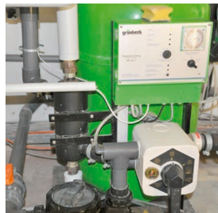
Schwimmbadwasserfilter. Der schwarze Zylinder links ist der Wärmetauscher für das Beckenwasser
