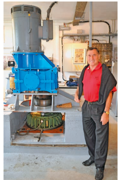
Hausherr Walter Settele vor dem 76-kW-Generator der Francis-Turbine
