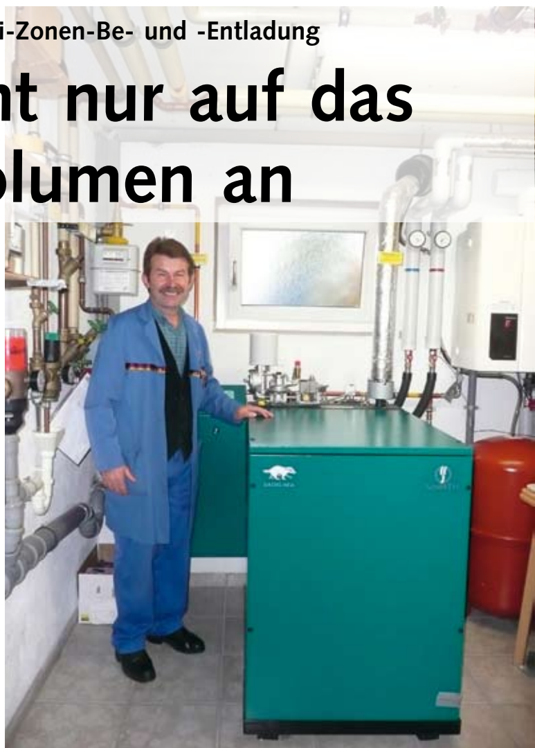
Bild 1 SHK-Unternehmer Günther Muck im Heizraum seines vermieteten Sechsfamilienhauses. Nach der Umstellung auf Zwei-Zonen-Be- und -Entladung des Pufferspeichers arbeitet das BHKW bis -10 °C Außentemperatur als monovalenter Wärmeerzeuger
